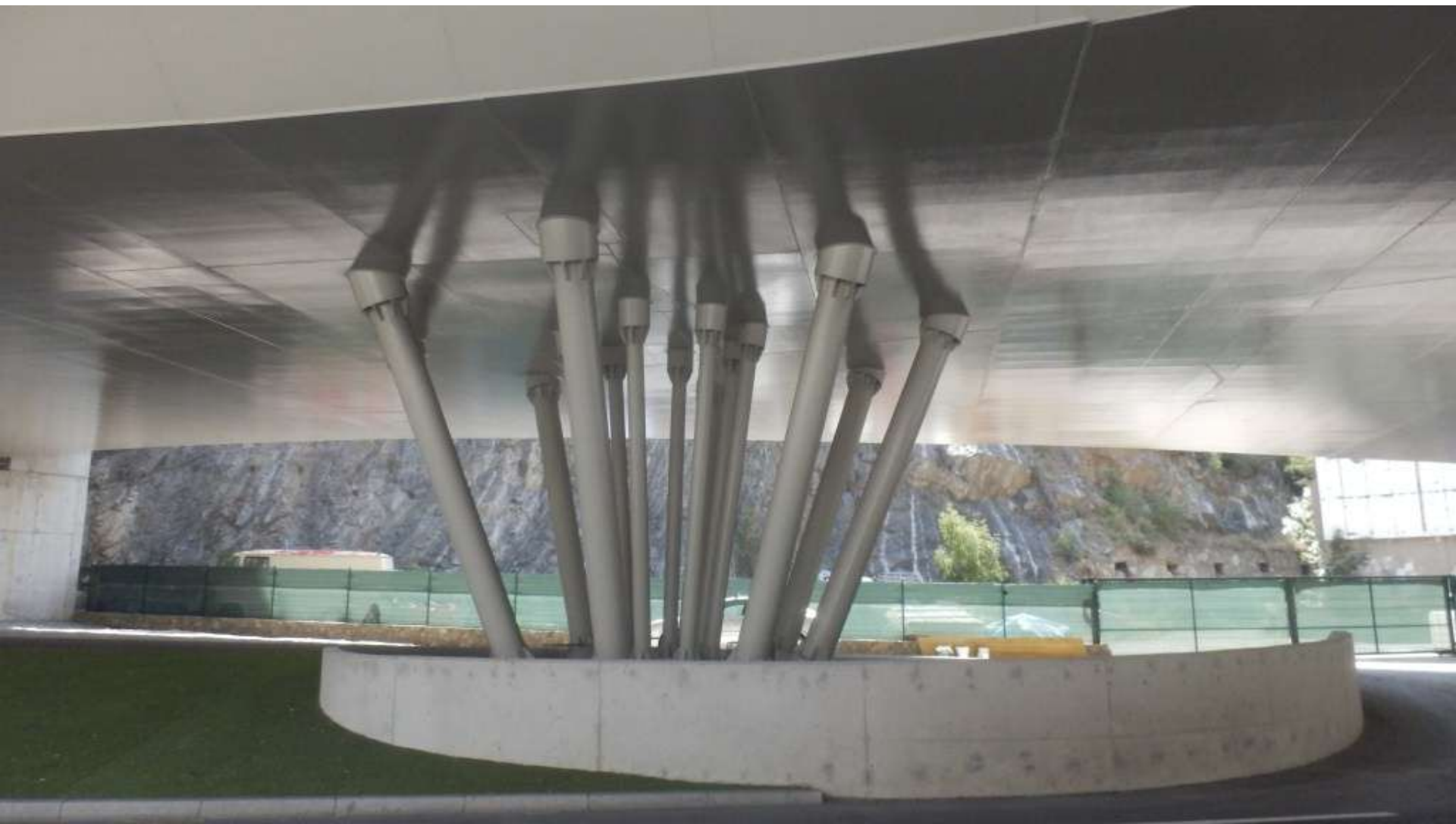
Podporni stebri ceste.
